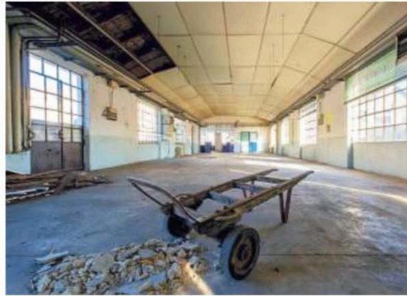
Fabbrichetta ad Arona: a maggio via ai lavori di ristrutturazione
